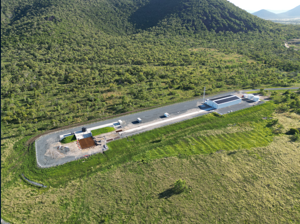
Una toma aérea del puerto espacial Bowen.
